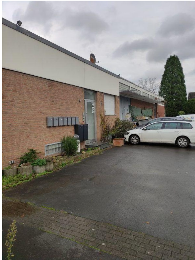
Parkplätze u. Eingang
