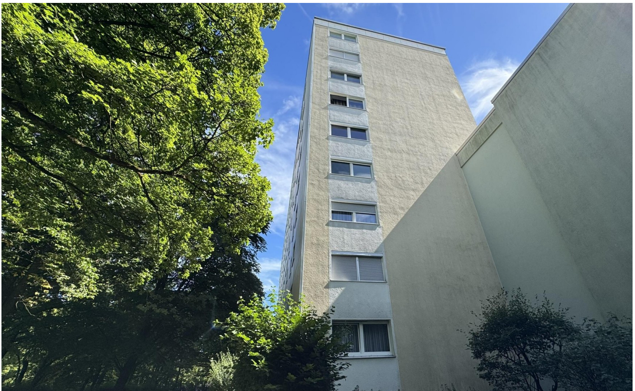
Gebäude von Außen
