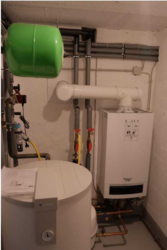
Heizung und Leitungen neu
