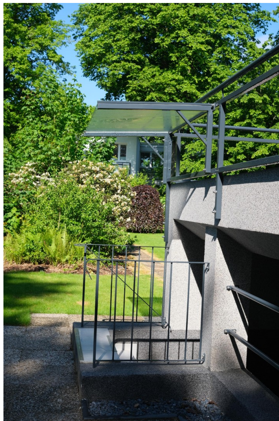
Glasdach zum Kellereingang
