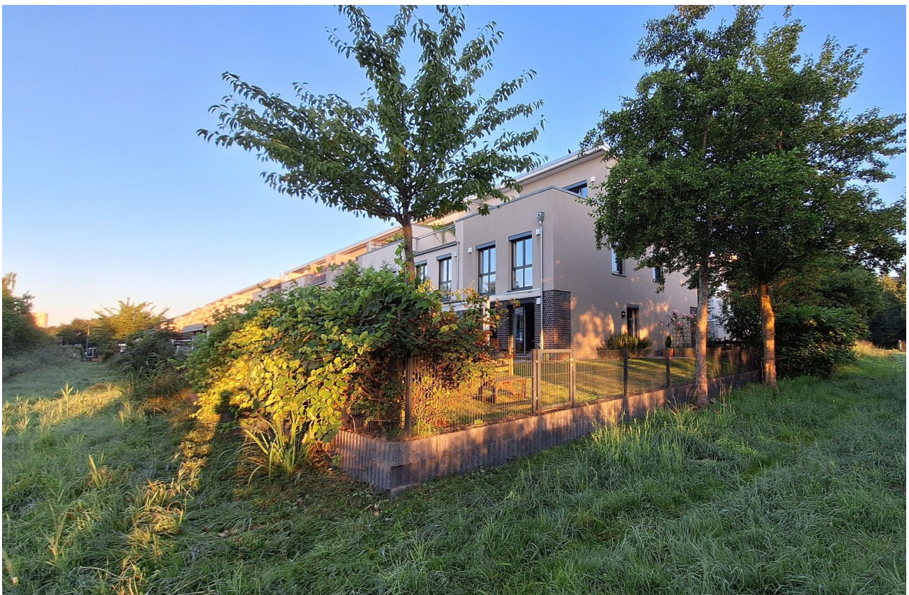
Panorama - Südostseite Haus
