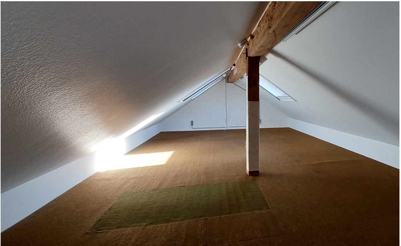
Dachboden mit Fenstern
