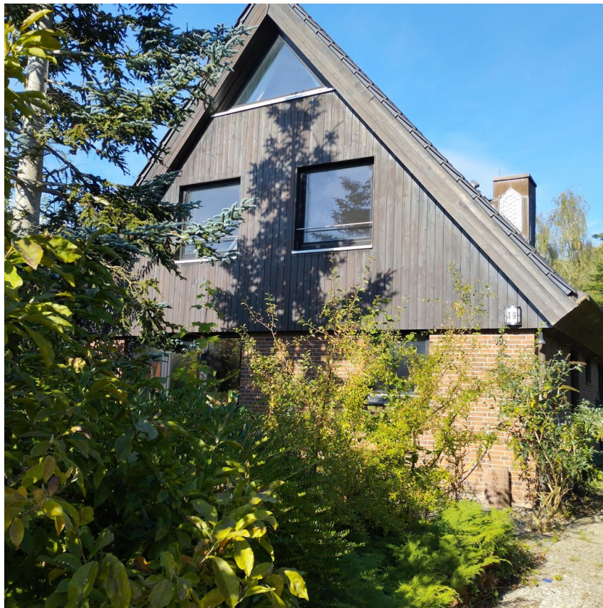
Ansicht von der Straße Am See
