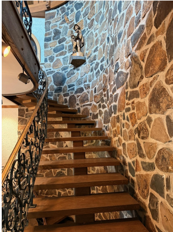
Treppe ins OG mit Basaltmauer
