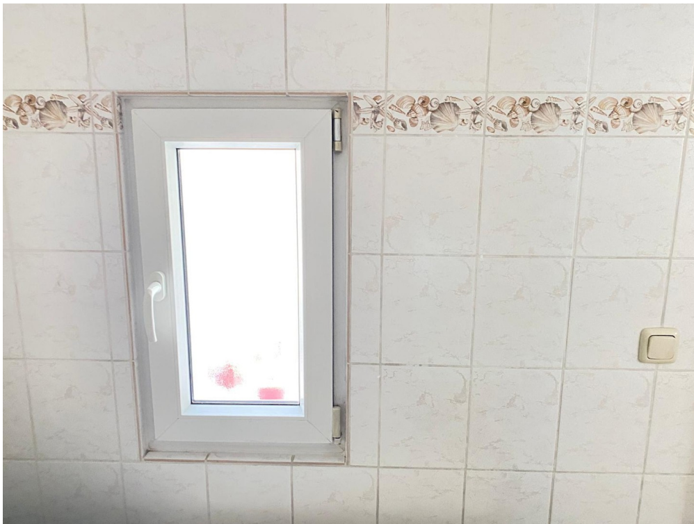
Fenster Duschbad EG
