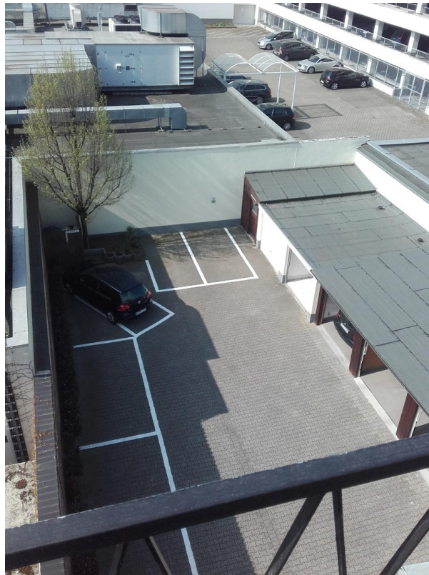
Innenhof mit Garagen/Stellpl.
