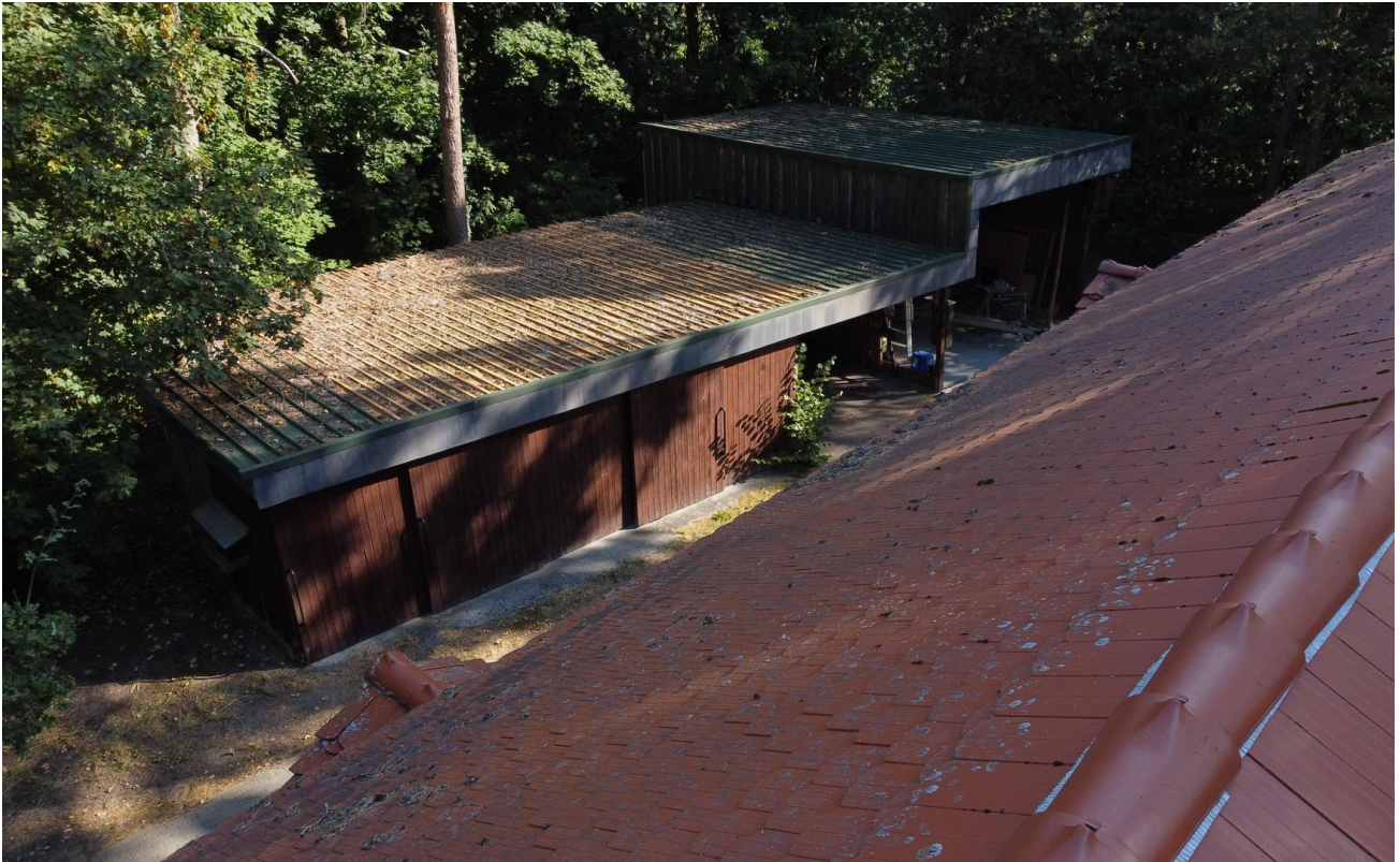
Garagen un Carports
