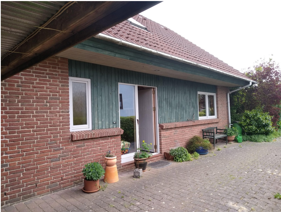
Eingang mit Auffahrt
