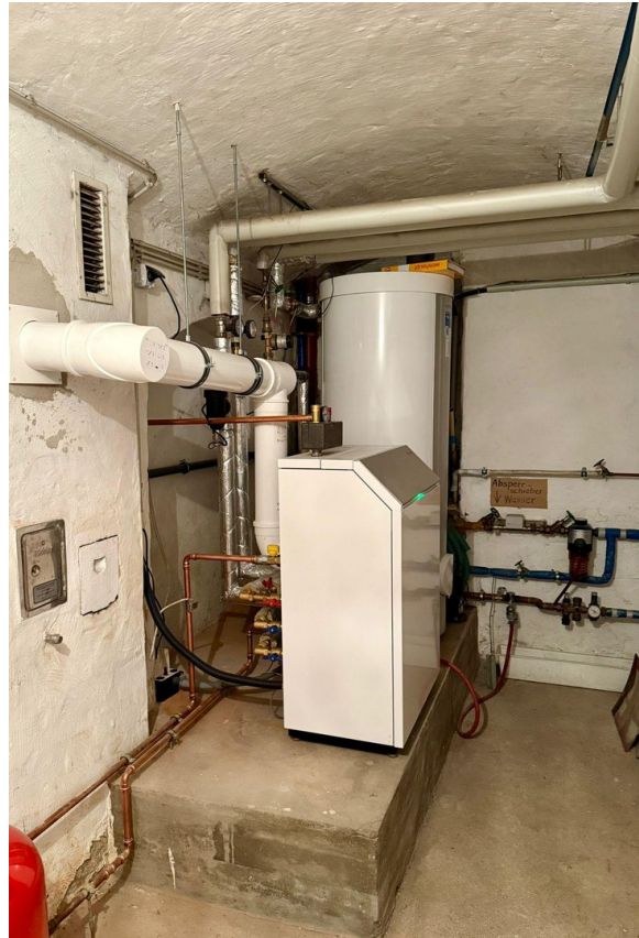
Brennwert Gas Heizung Bj. 2023
