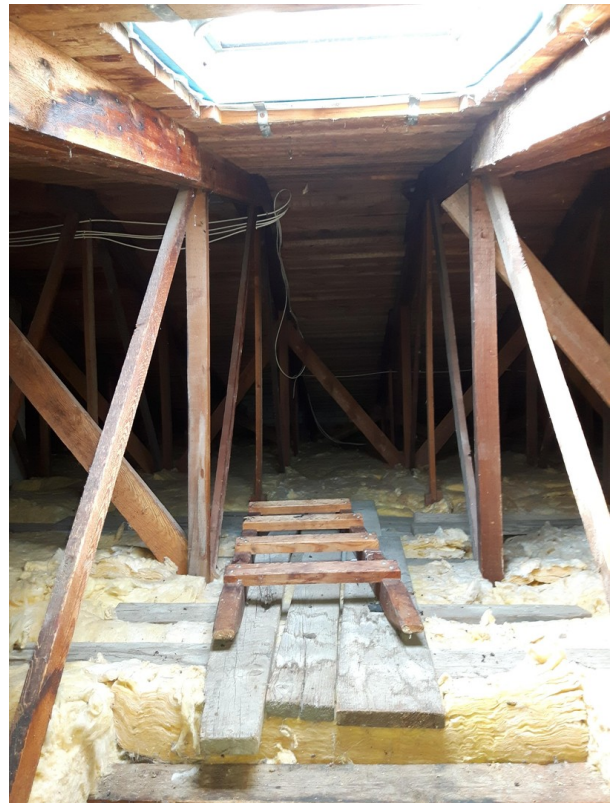
Oberste Decke Gedämmt
