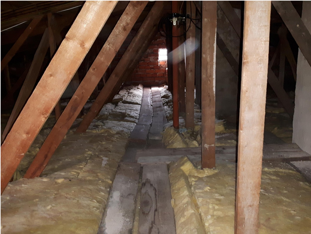
Oberste Decke Gedämmt
