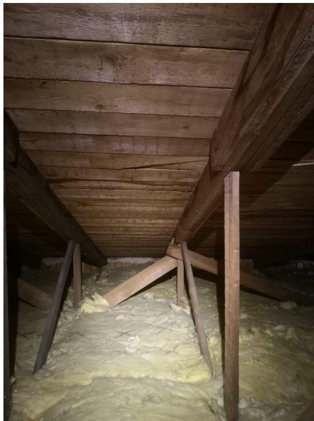
Oberste Decke Gedämmt
