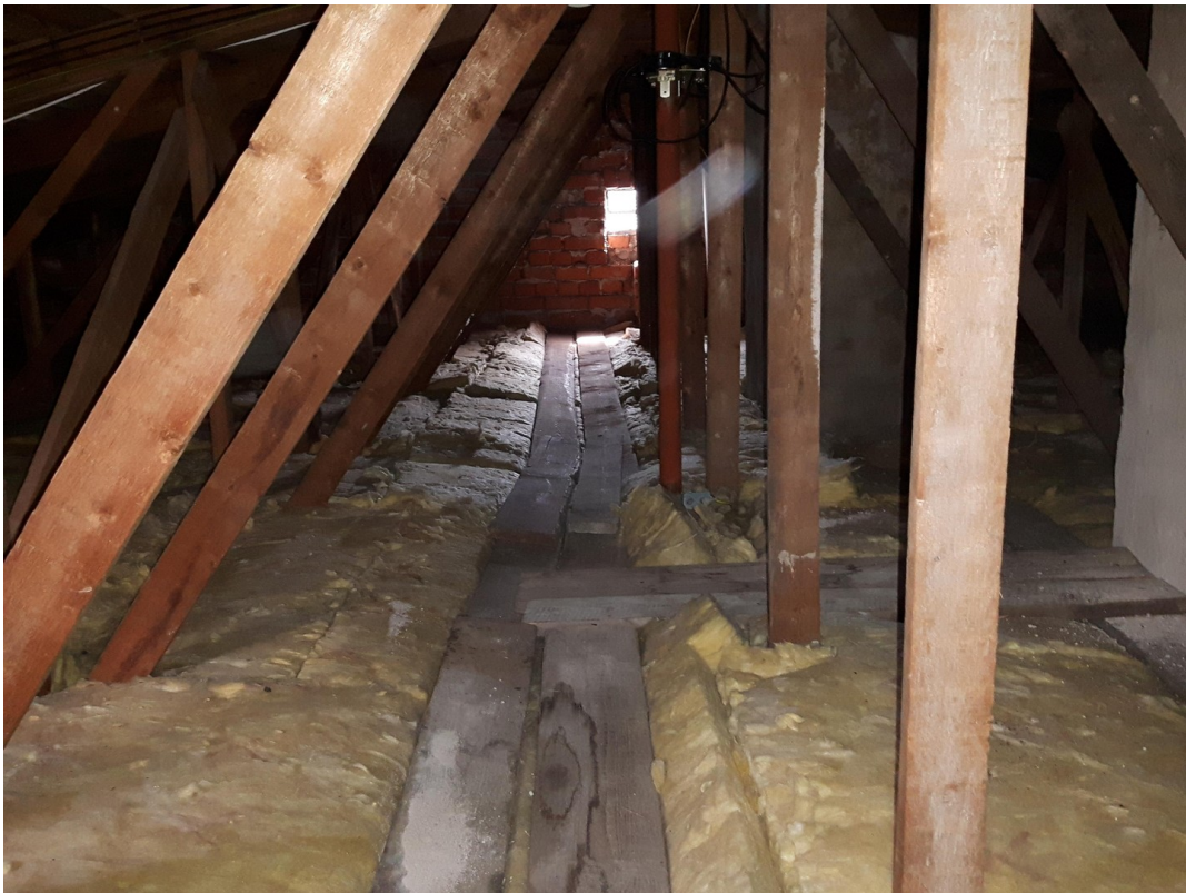
Oberste Decke Gedämmt
