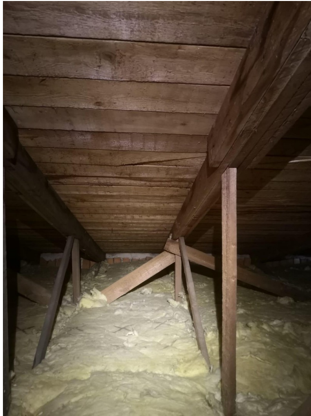
Oberste Decke Gedämmt
