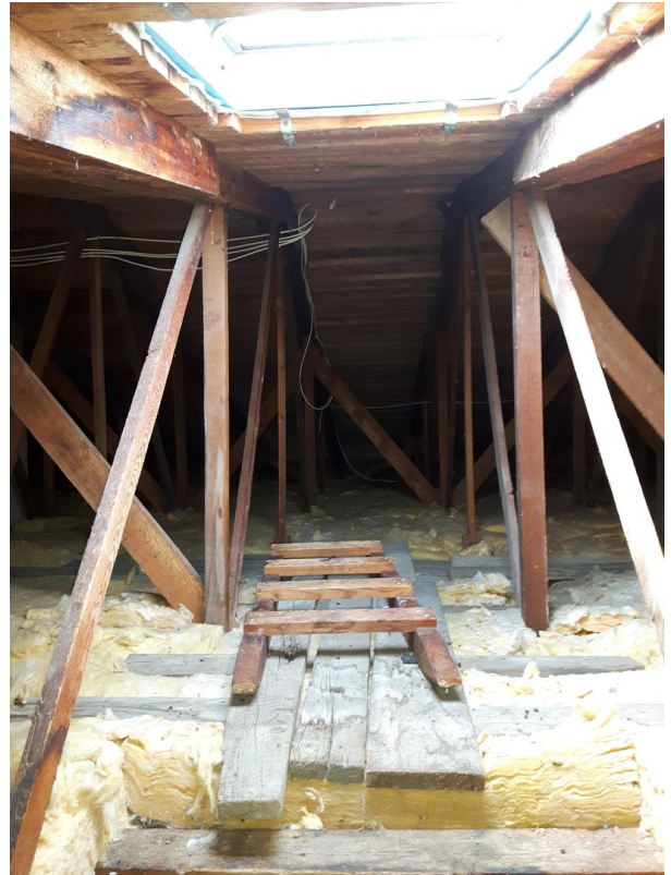
Oberste Decke Gedämmt
