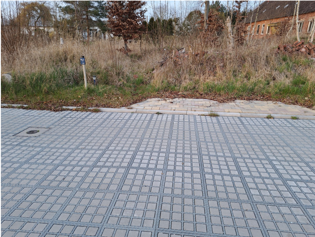
Straße mit Anschluss Wasser
