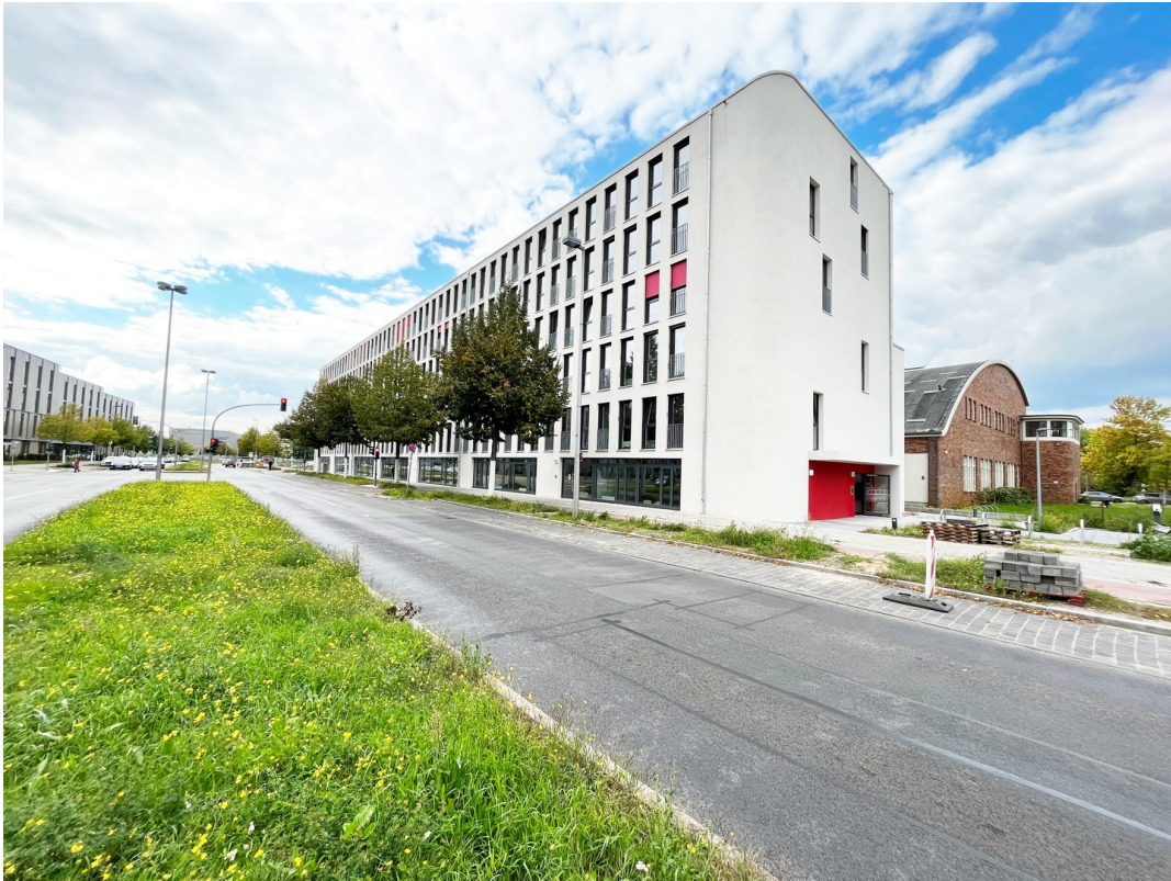
Gebäudefassade und Umgebung
