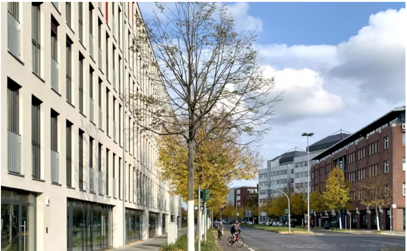
Gebäudefassade und Umgebung
