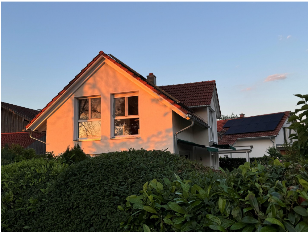
Westseite des Hauses
