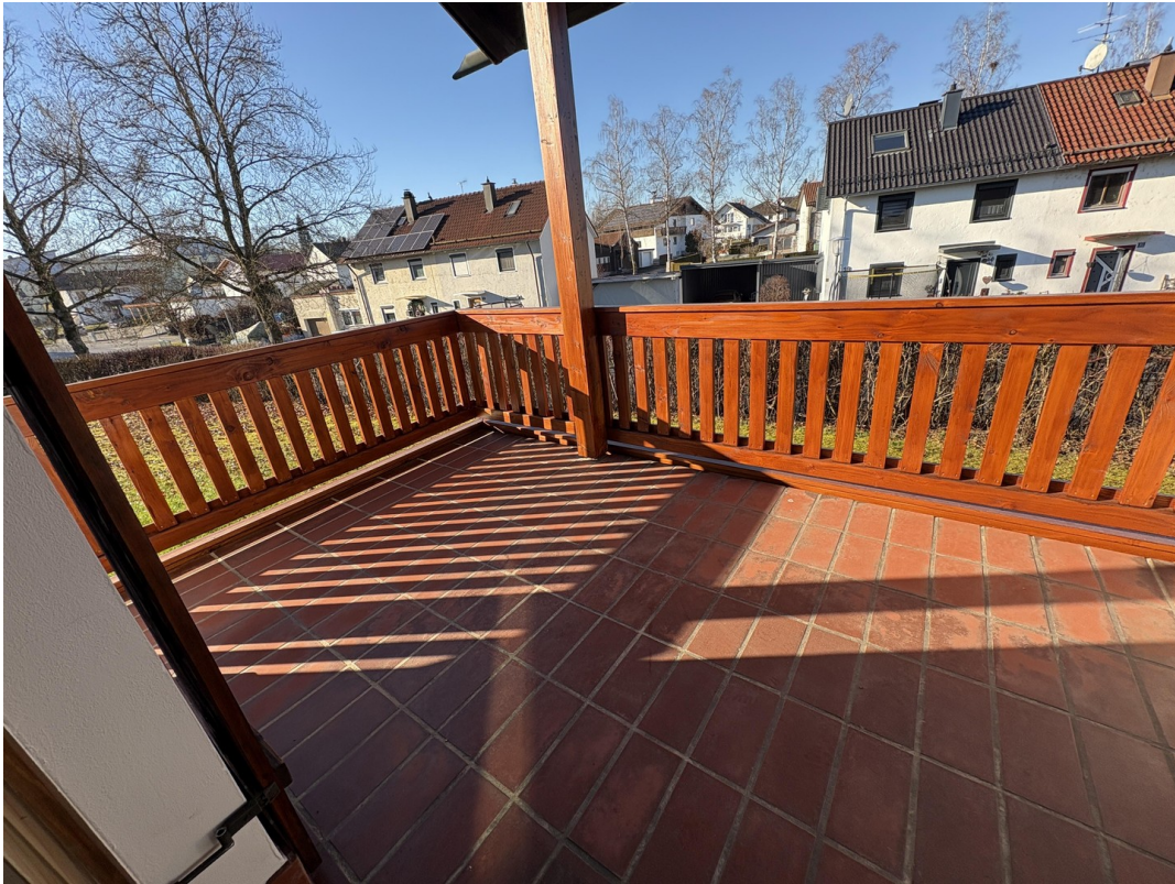
Balkon beim Wohnzimmer
