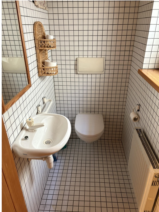
WC im Keller
