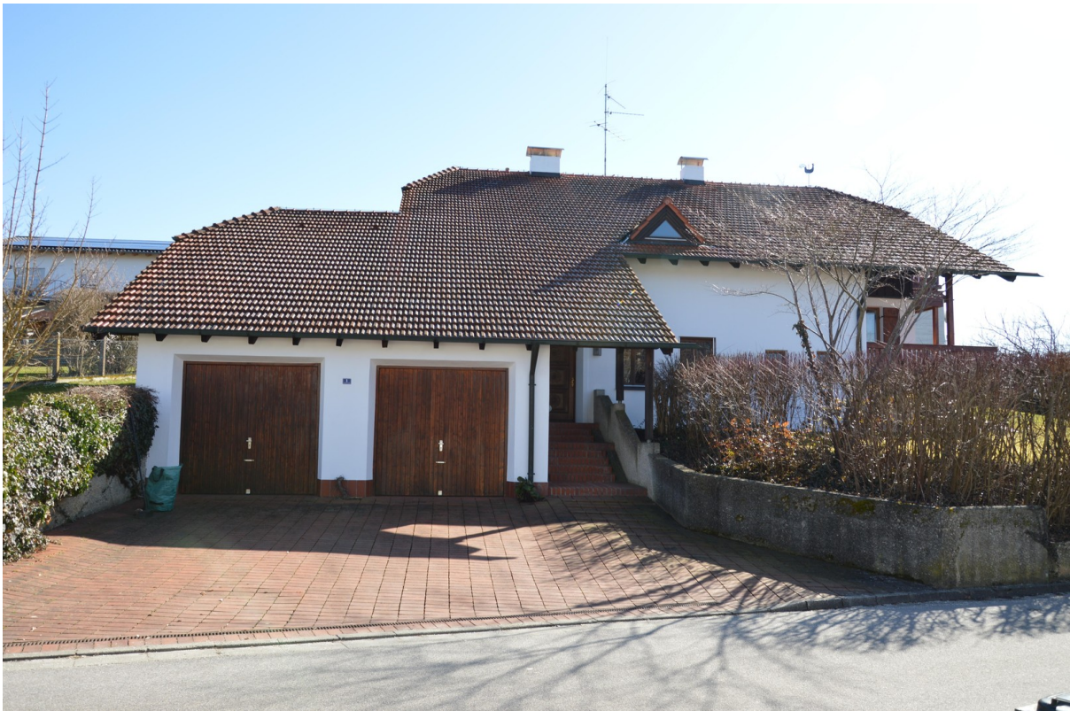
Eingang mit Garagen
