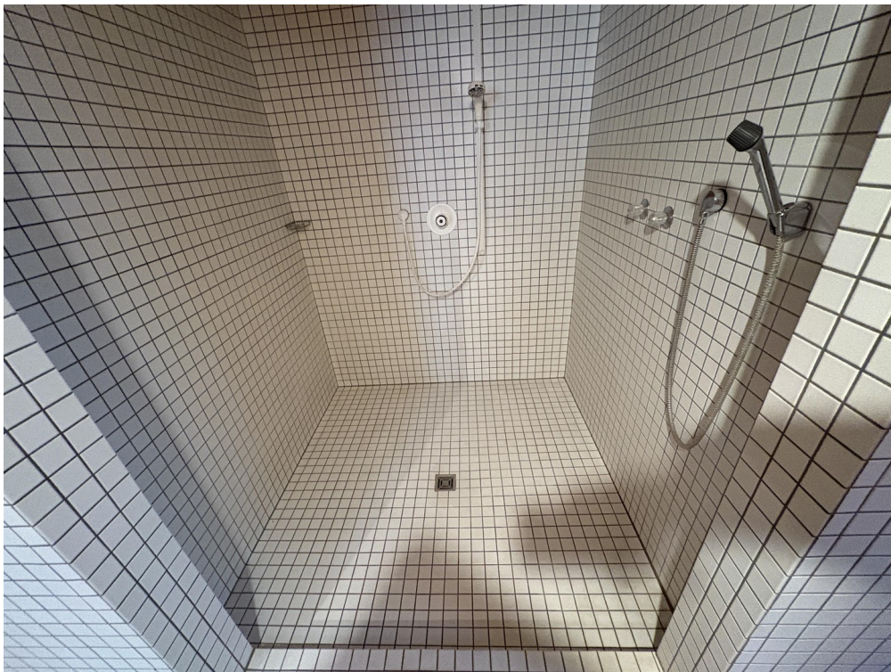
Dusche im Saunabereich
