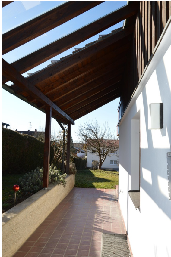
Überdachte Freifläche, Küche
