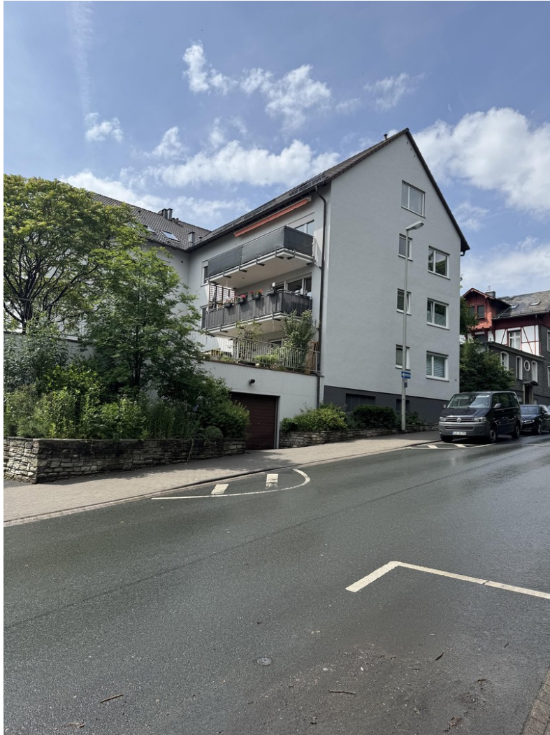
Ansicht von der Strassenseite
