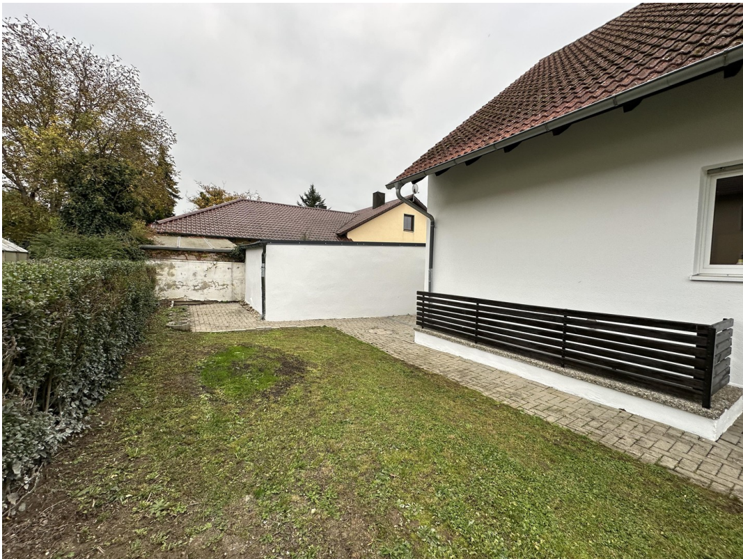
Garten Blick West Kellerabgang
