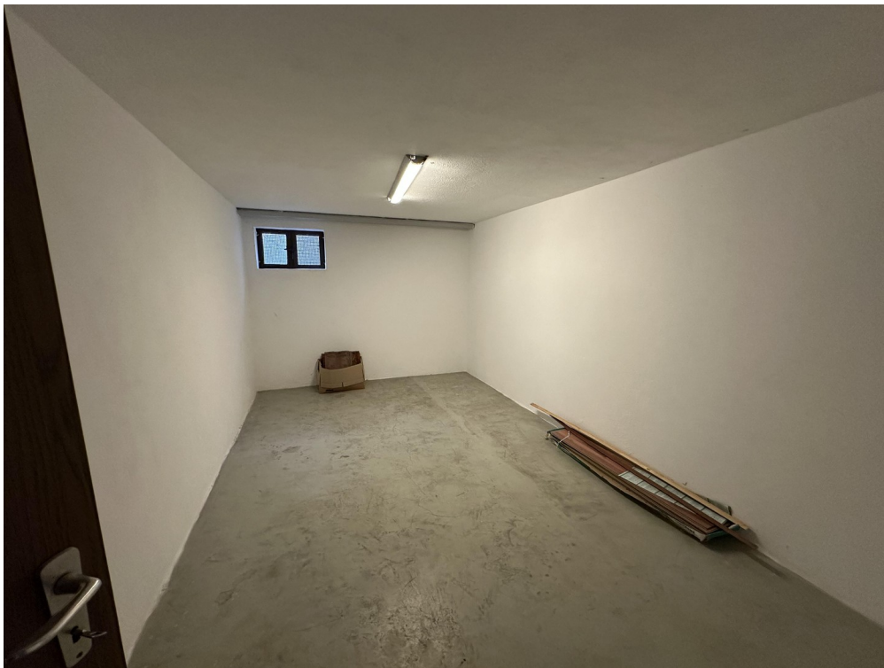
Keller unter Kinderzimmer
