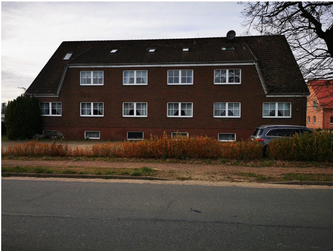
Ansicht Haus 1 Strassenseite
