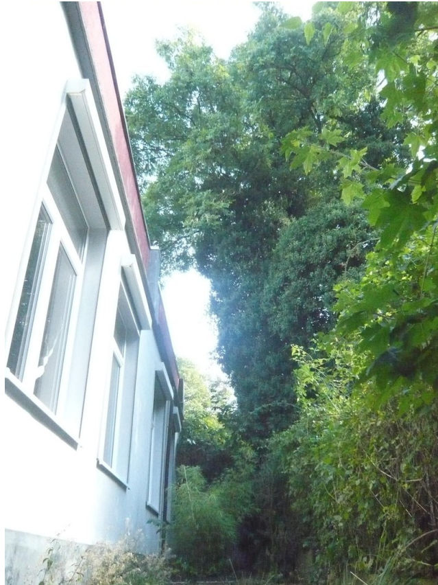
Fassade SW Wohnen
