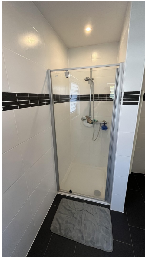
Bad 2 OG Dusche
