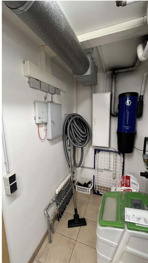
Technik UG - Staubsaugeranlage
