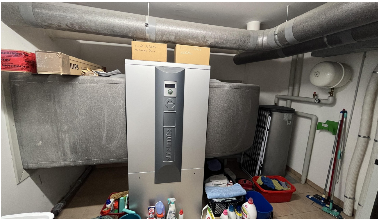
Technik UG - Wärmepumpe
