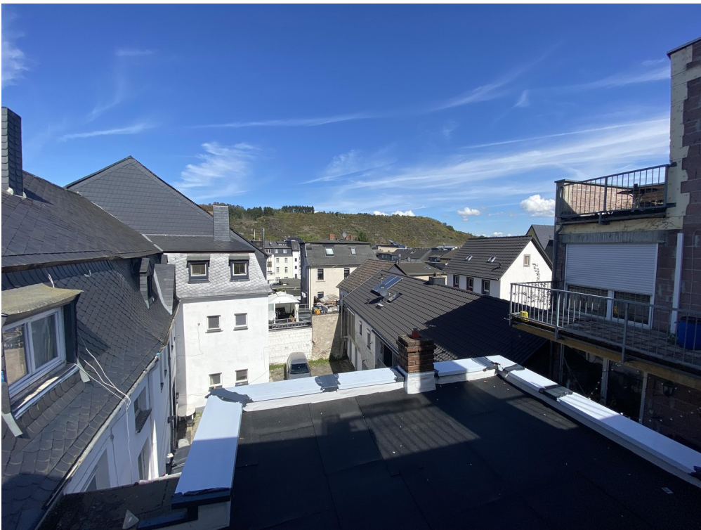
Dachterrasse in Fertigstellung
