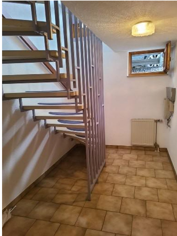
Treppe zum Keller
