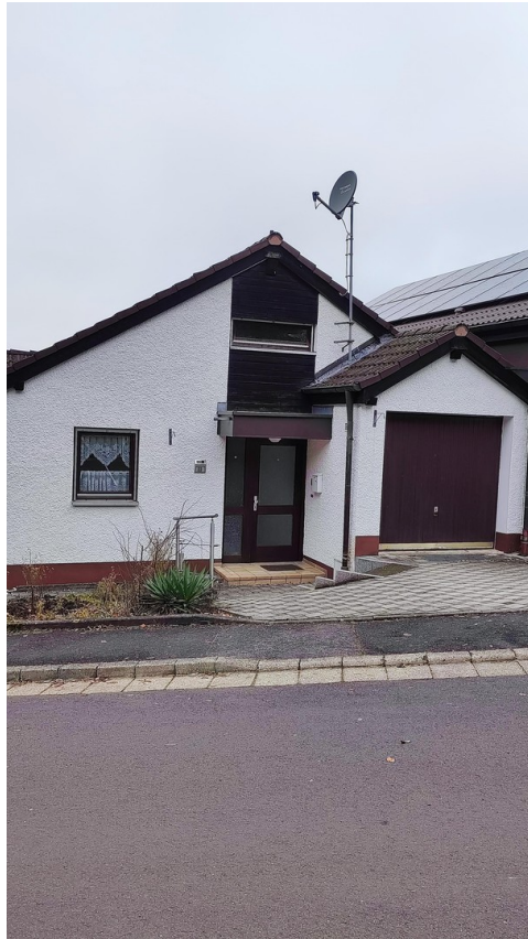
Eingang mit Garage
