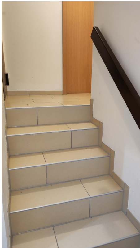
Treppenaufgang zum Heizraum
