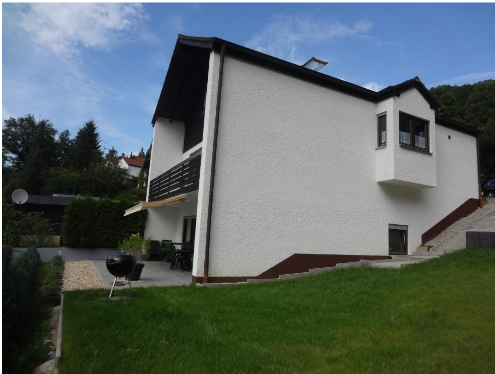
Hausansicht von Süden
