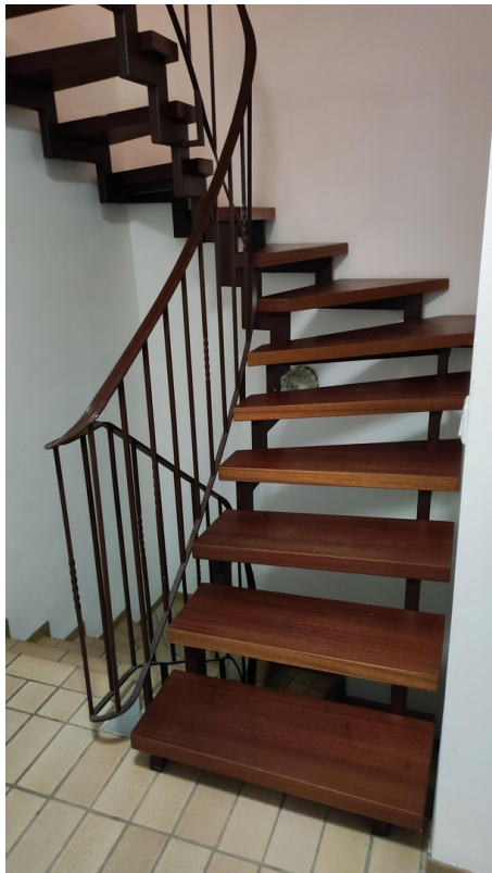
Treppenaufgang zum OG
