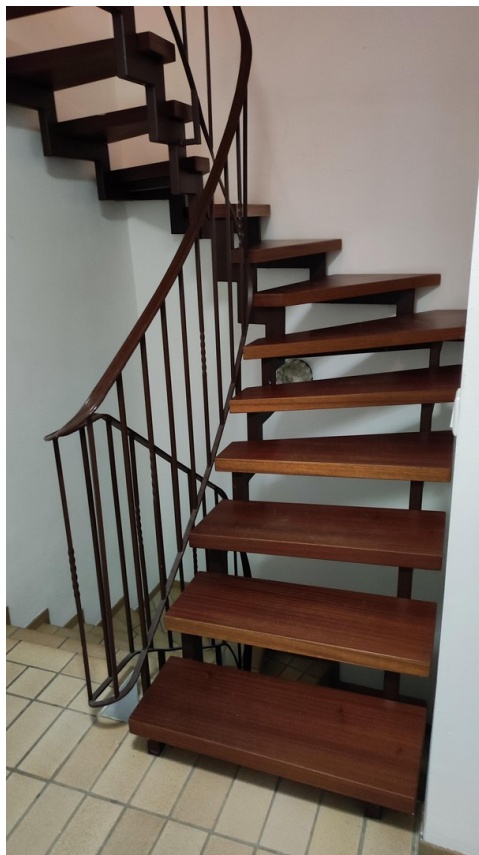
Treppenaufgang zum OG
