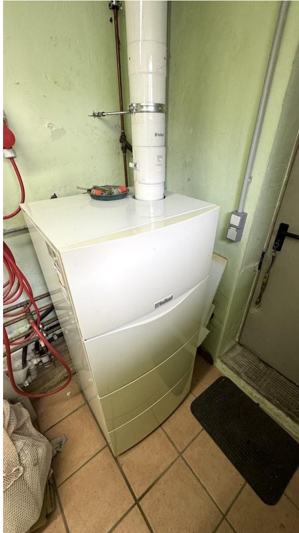
Gas-Brennwertgerät
