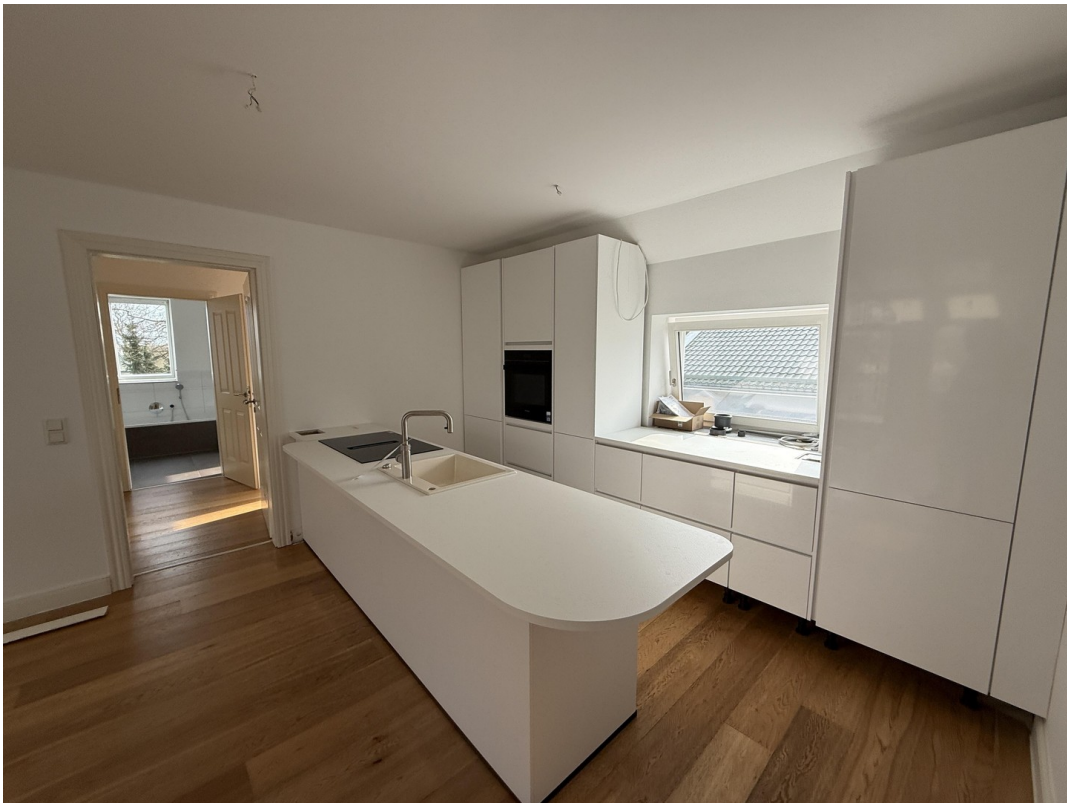
Küche im Aufbau
