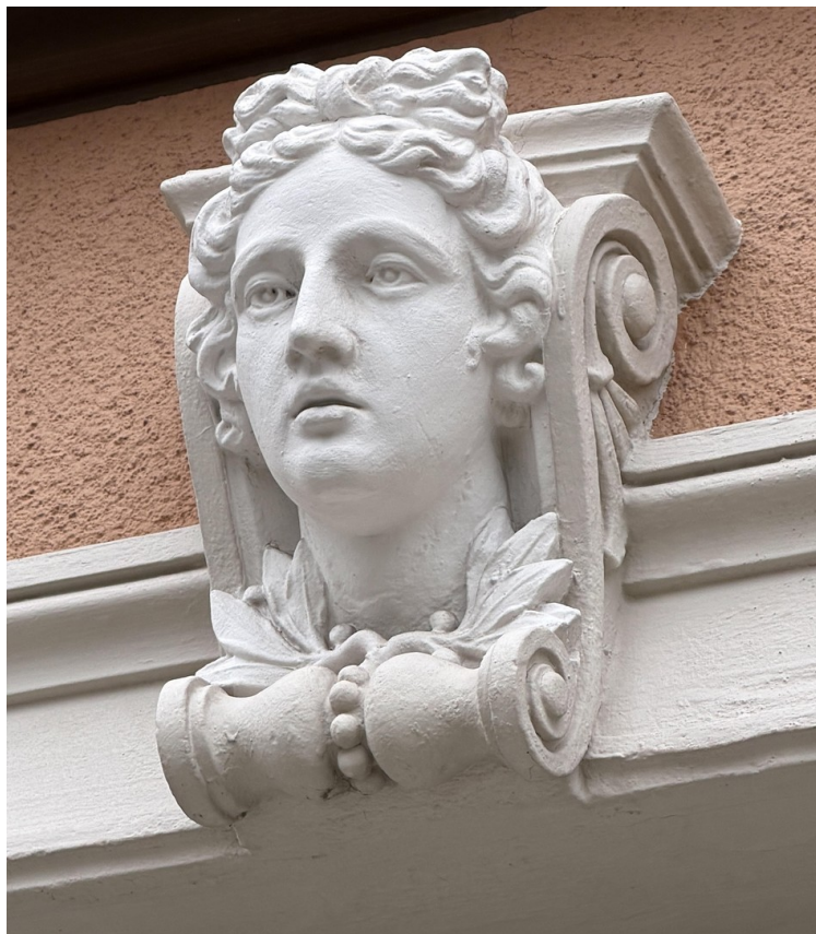
Kopf über Fenstergewand
