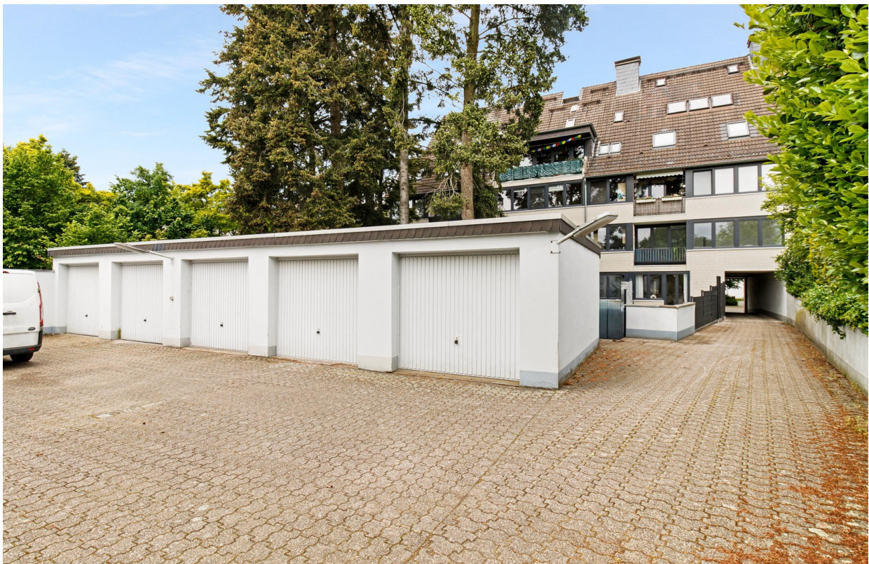
Ansicht vom Garagenhof
