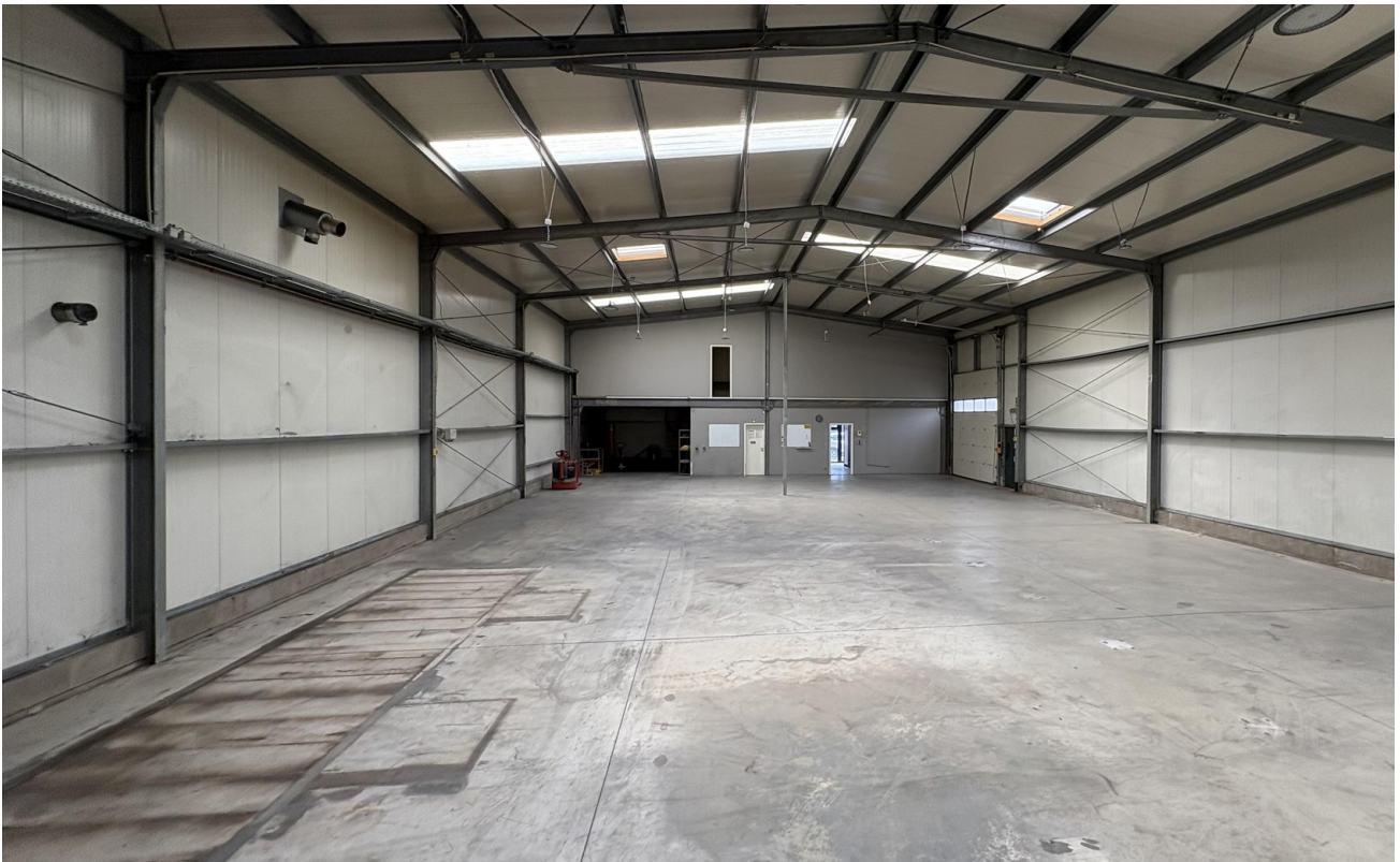
Halle Teil A - Süd
