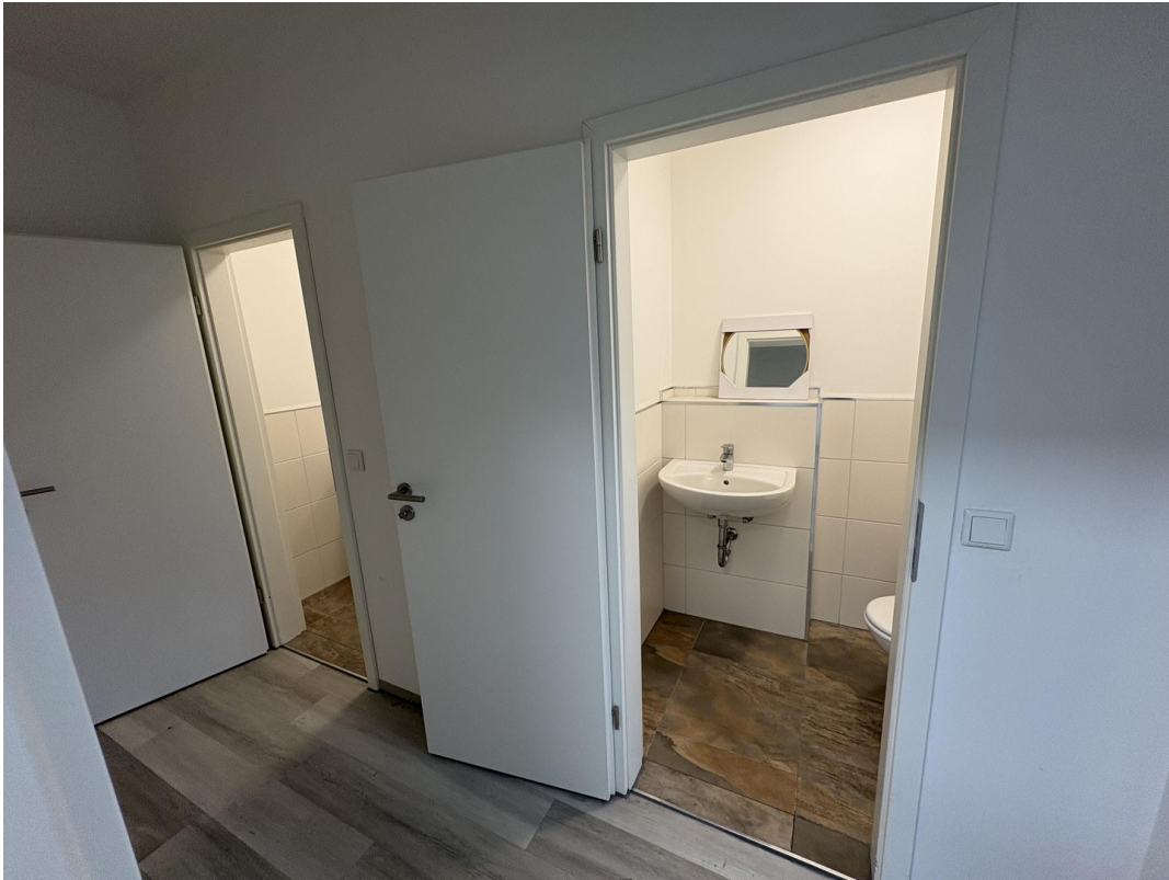
Toiletten Teil B 2
