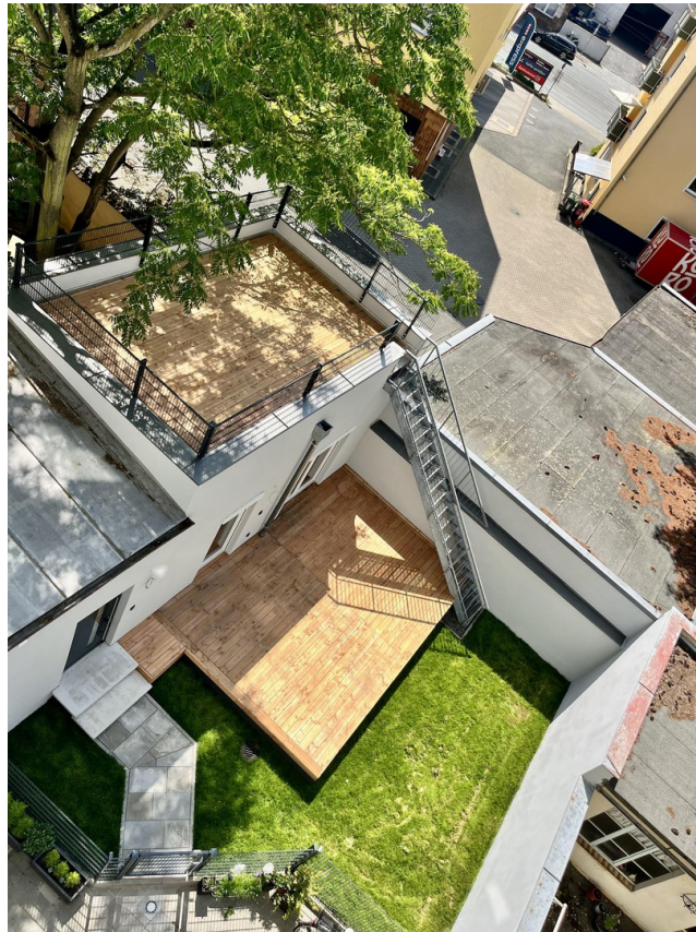
Dachterrasse und Terrasse
