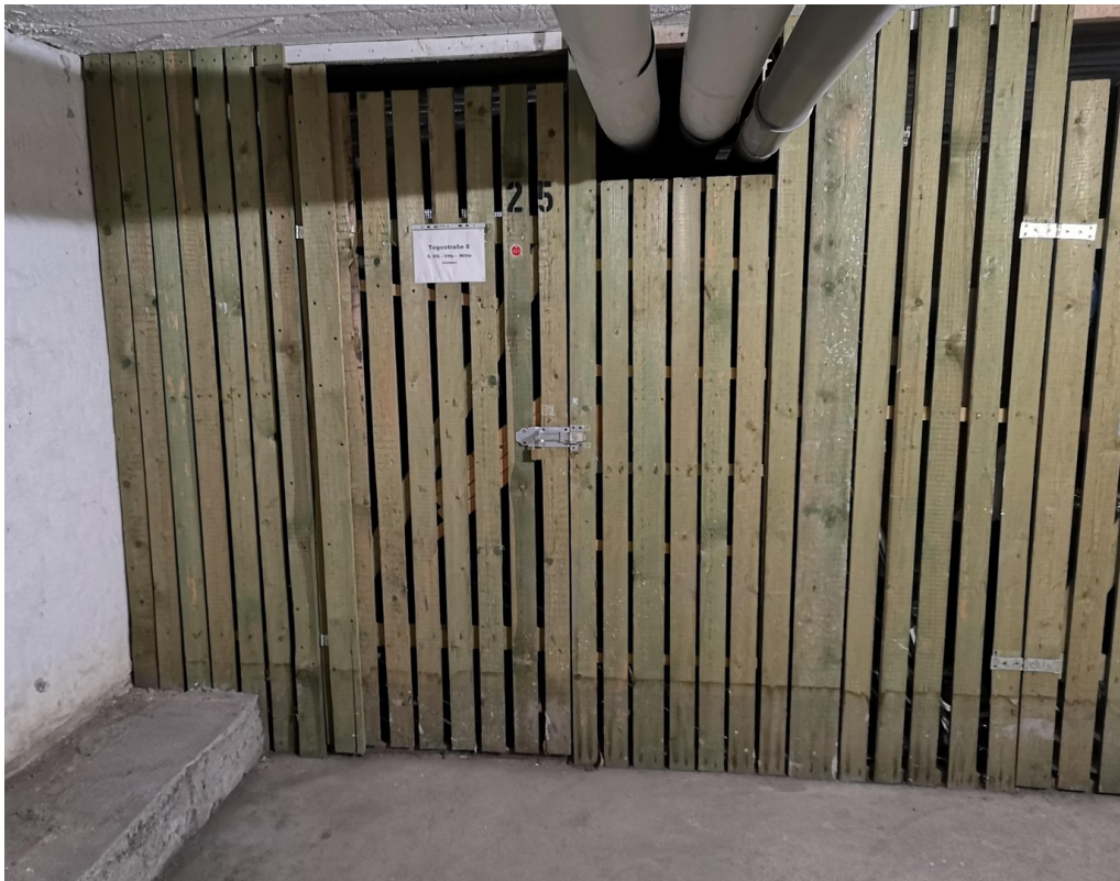
Keller: trocken und gepflegt
