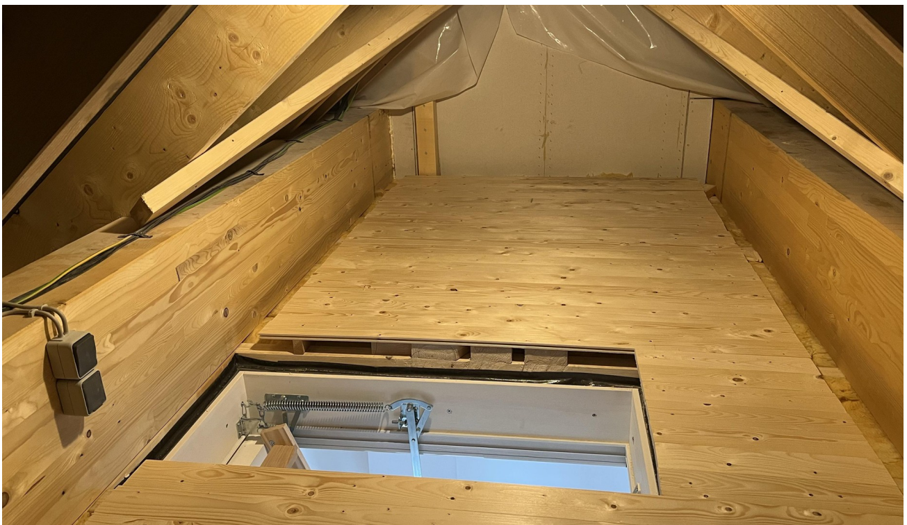
Spitzboden als Abstellraum
