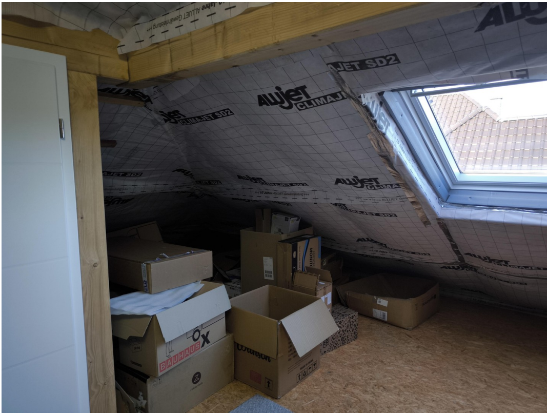
Dachgeschoss mit Fenstern
