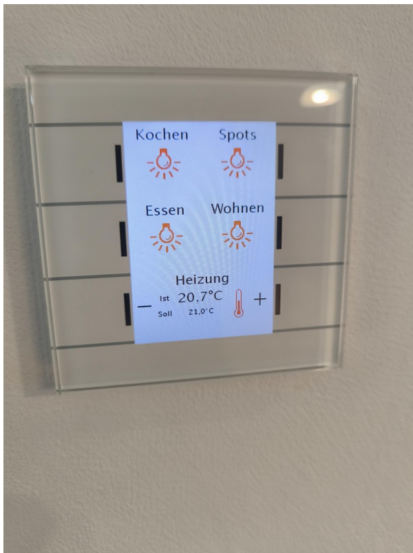
Steuerung KNX
