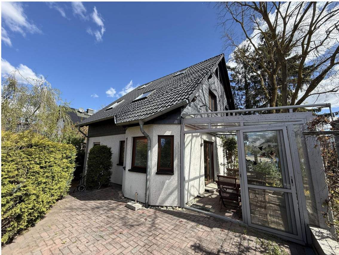
Terrasse mit Überdachung
