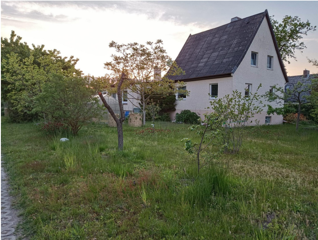
Haus Ansicht von der Straße
