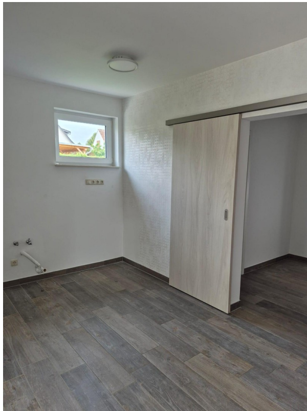
Haus 2 Küchen Bereich
