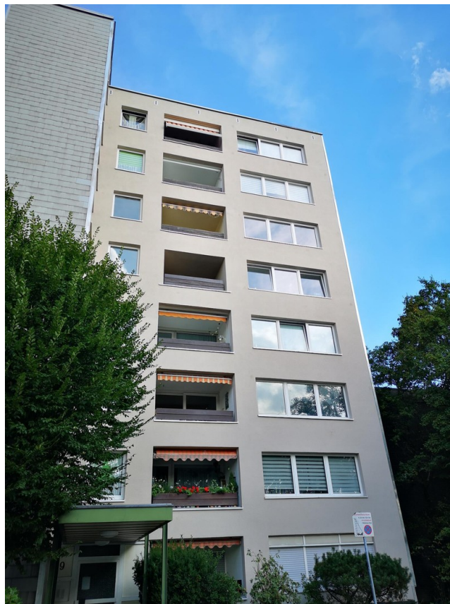
Frisch sanierte Fassade
