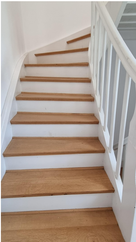
Treppe zum OG
