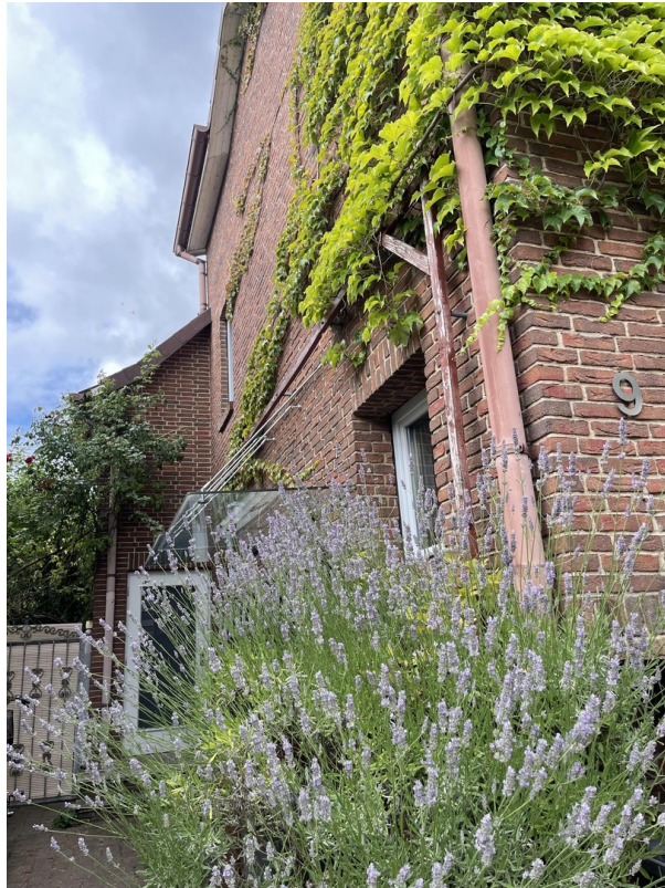
Blick zum Durchgang
