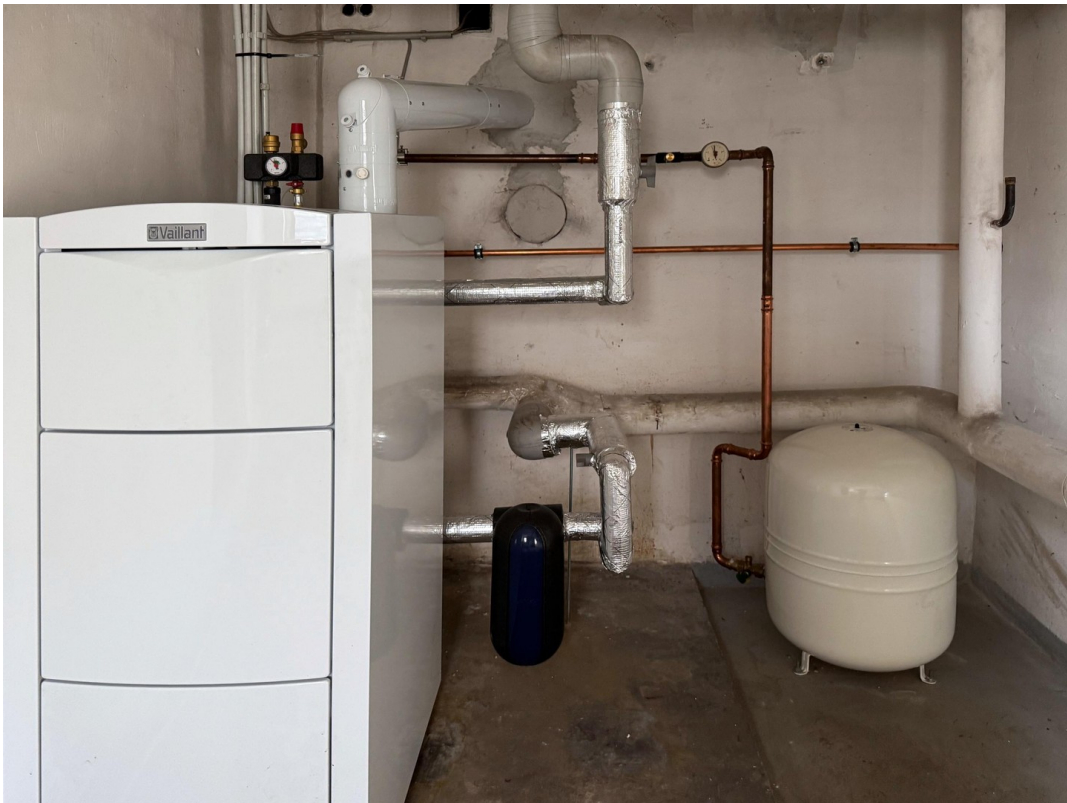
Neue Brennwert-Zentralheizung
