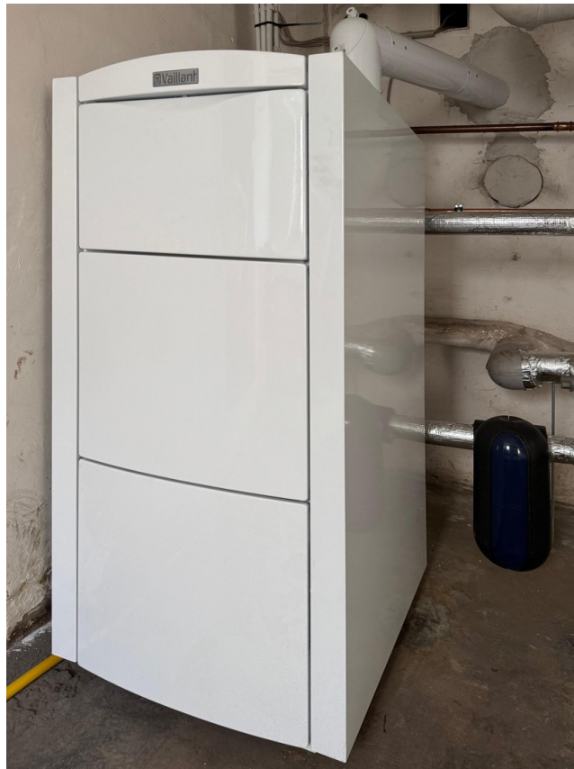
Neue Brennwert-Zentralheizung
