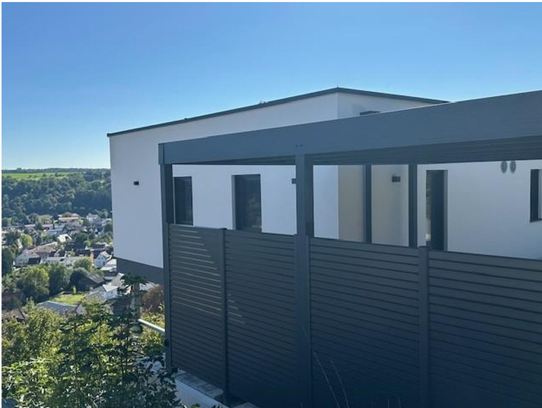
links mit Carport
