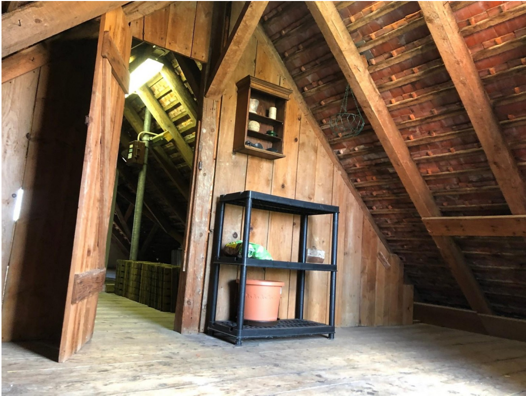
Aufgang zum Dachboden
