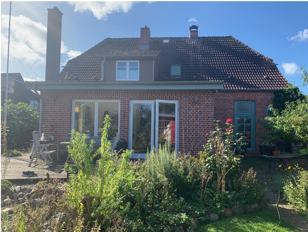
Nordansicht mit Anbau
