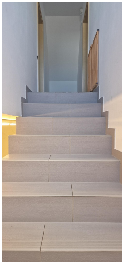
Treppe zum OG
