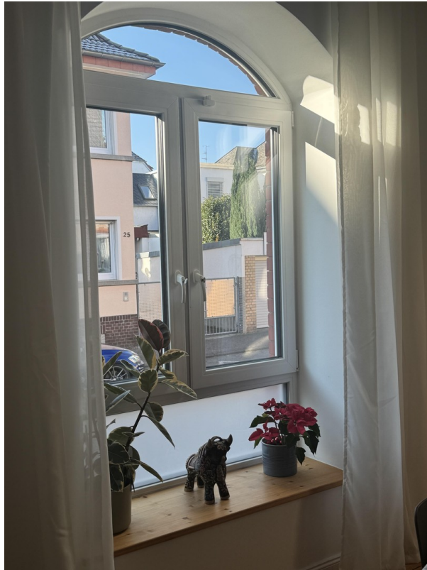
3-fach verglaste neue Fenster
