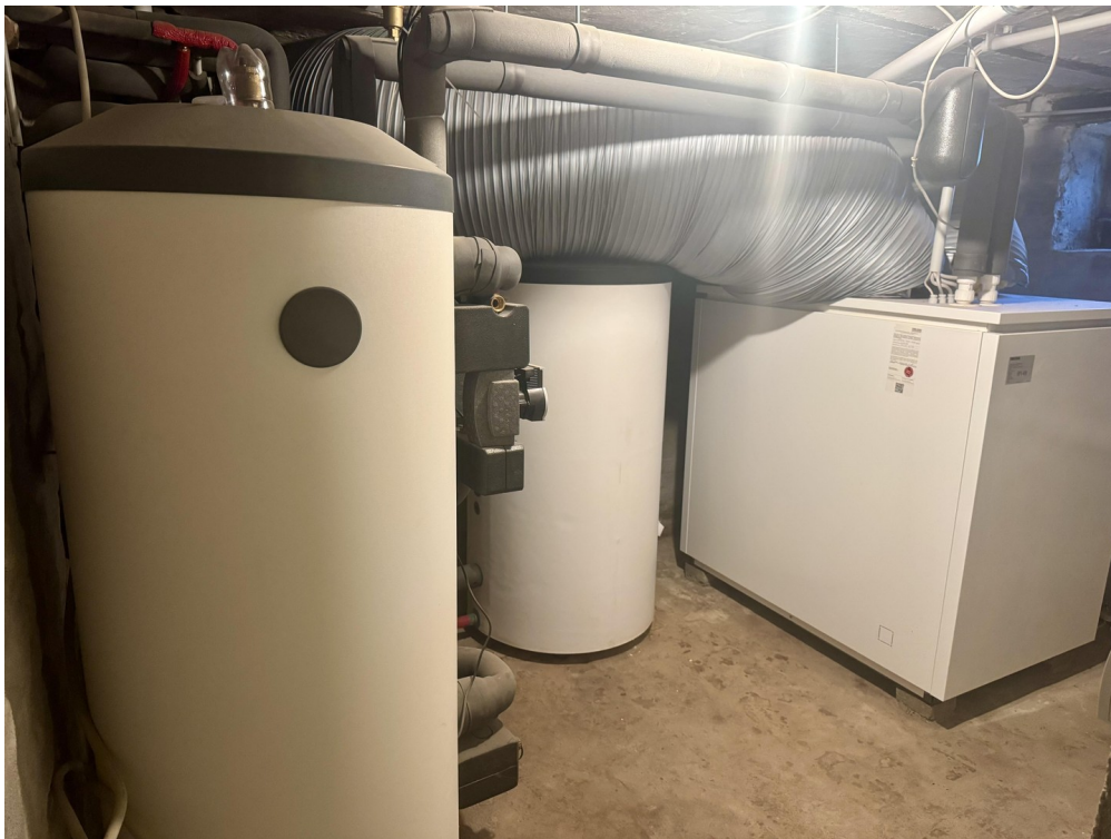
Innenliegende Wärmepumpe
