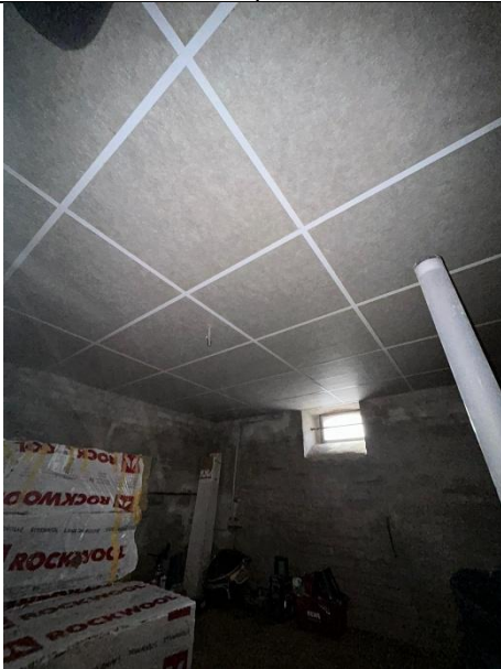
Deckenisolierung Rockwool
