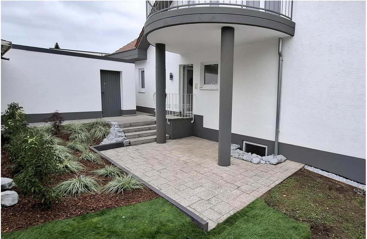
Terrasse und Balkon 1.OG
