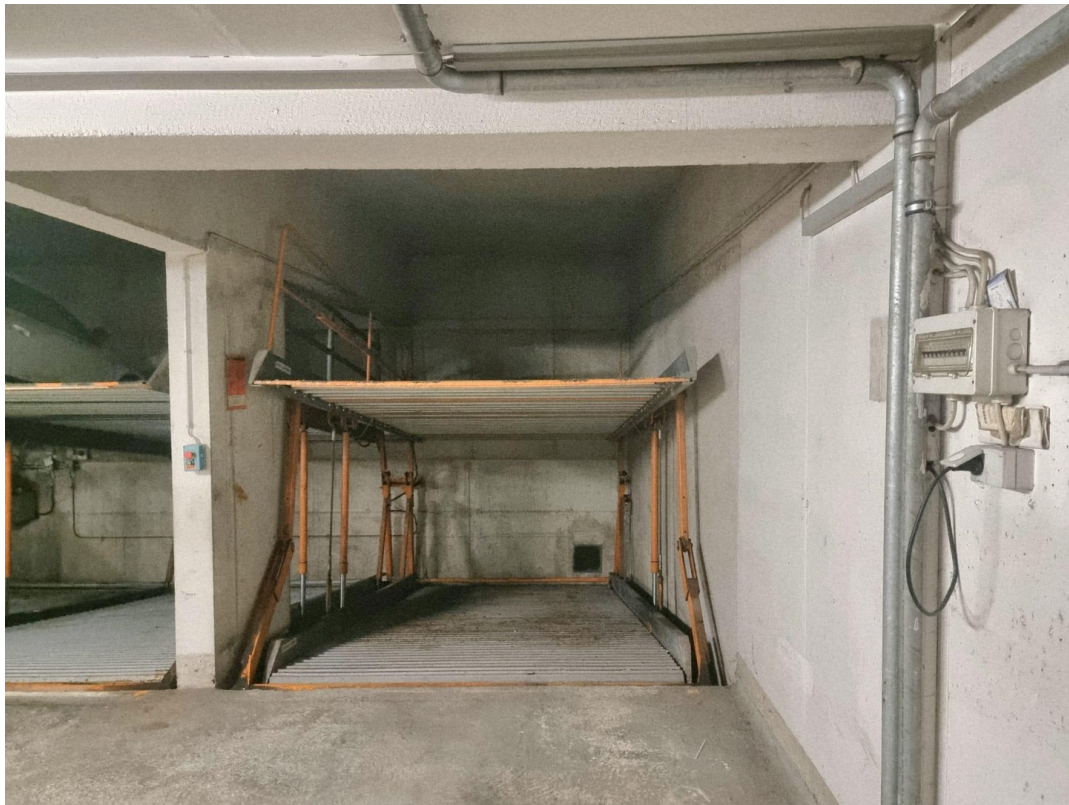
Tiefgarage Duplex Stellplatz
