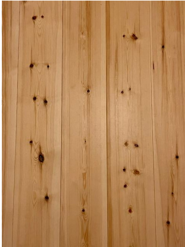
Dielen Flur und Küchenbereich
